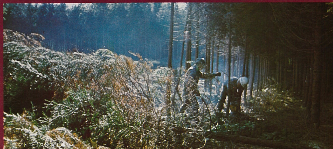
アウトコース伐倒工事
