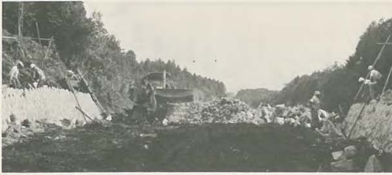
急ピッチで進む砂沢川改修工事
