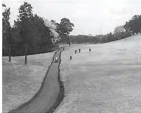
完了した北1番ホールのカート路拡幅・延長工事。
