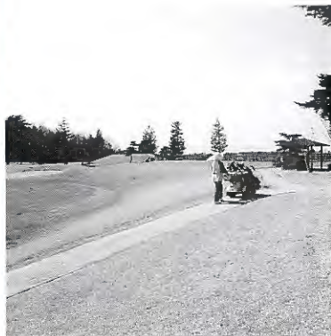
南14番ベントグリーン端より同15番までのカート路に砂入人工芝を敷設
