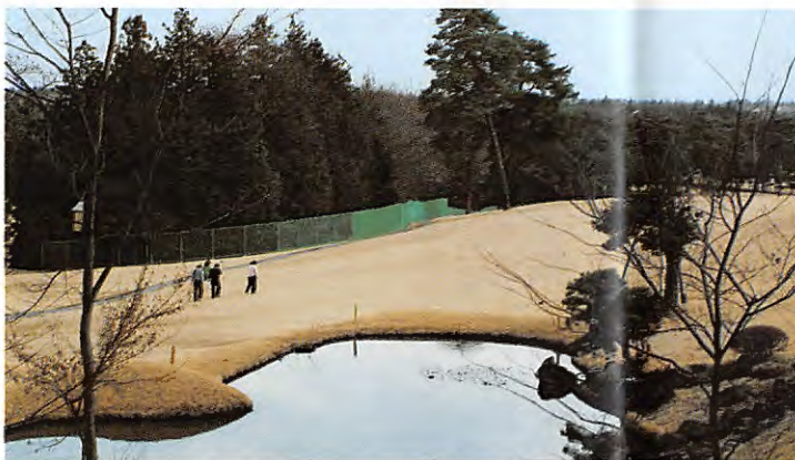
北1番ミドルホールの左側ラフ部分に新設された防球ネット
