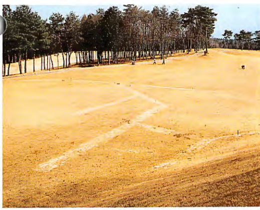
フェアウェイの排水工事が完了した南15番ミドルホール
