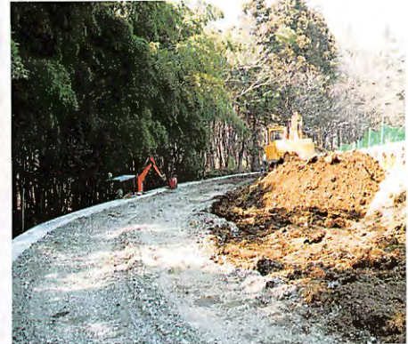
作業が進められている北15番ミドルホールのカート路造成工事
