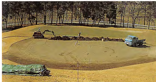
改造工事が進められている北14番ベントグリーン
