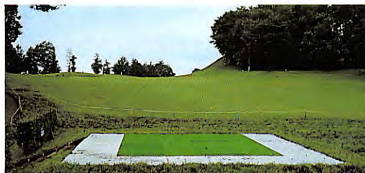
特設ティーの新設工事が進められている北・18番ティーグラウンド
