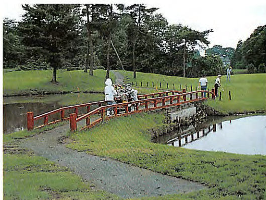
橋梁の補強修理が行われている北・16番
