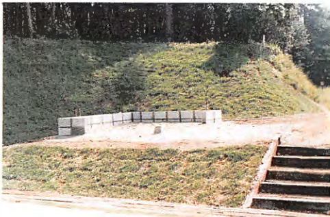
基礎工事に取っかかった南9番の東屋
