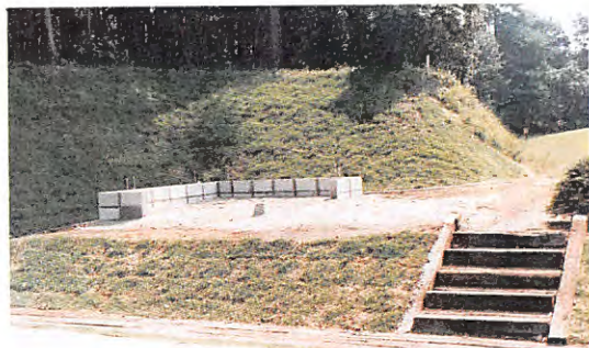
基礎工事に取掛かった南9番の東屋
