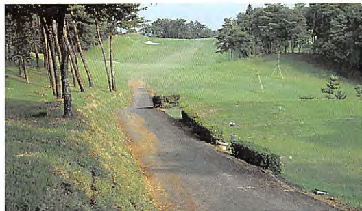
舗装された南11番ティーグラウンドわきのカート路
