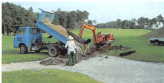
排水工事が進む南15番のサイドバンカー
