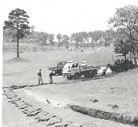
南17番ホールの排水工事
