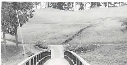
南13番グリーンから黄金橋梁の歩経路兼カート路
