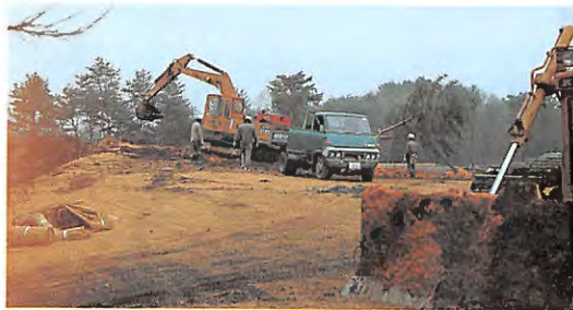
南14・15番の改造工事
