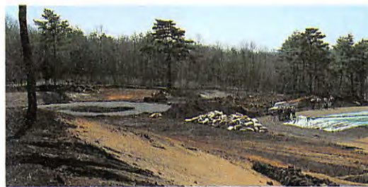
黄金3番グリーン移設工事
