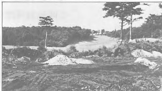
黄金3番ホール・グリーン移設工事
