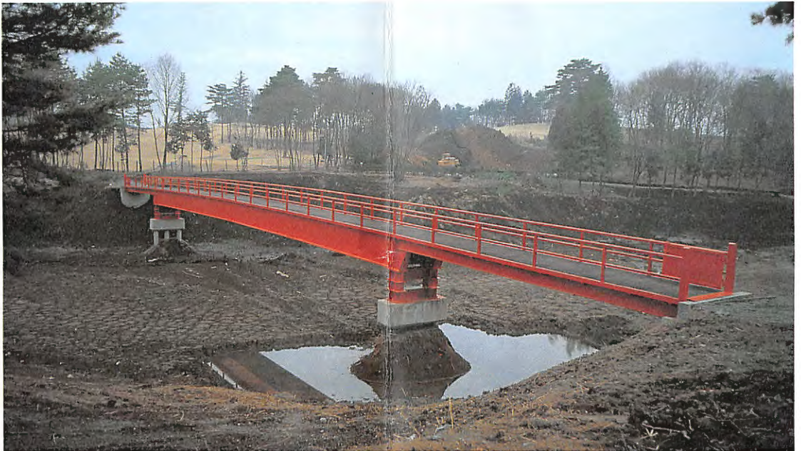
歩径路短縮のため架設された「黄金溜の橋梁」
